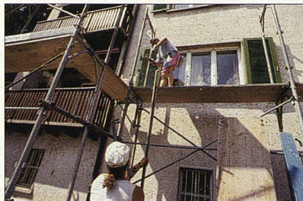
Nach den notwendigen Rodungen wird das Gerüst hochgezogen und anschliessend das Haus eingestutzt.
