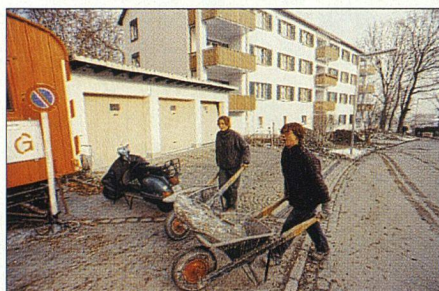
Die Bauarbeiten haben einige Spuren im Aussenraum hinterlassen. Die Gärtnerinnen bringen die Sache wieder in Ordnung.
