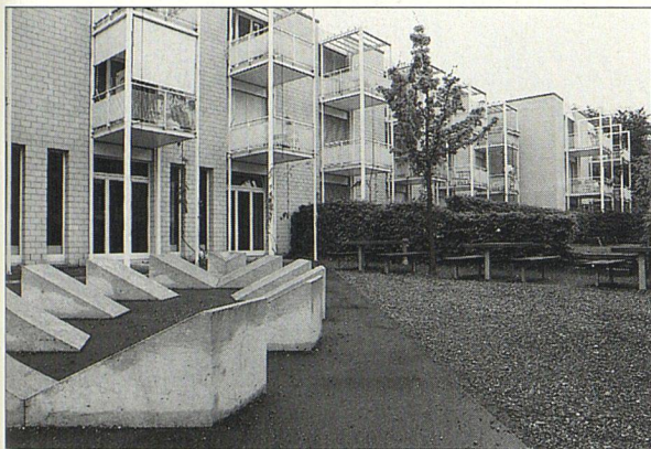
Sanierungsfall am Sonnenhang: Siedlung «im Trichtisal» in Zürich
