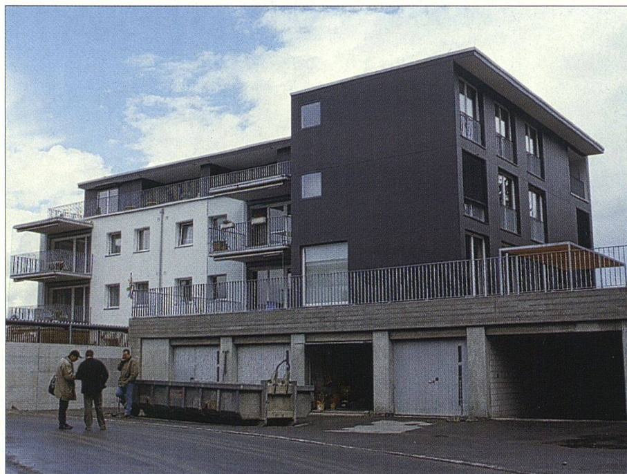
Nach der Sanierung: Die bestehenden Baukörper wurden weiss, die neuen anthrazitfarben gestrichen. Die Balkone sind jetzt vorgelagert.
