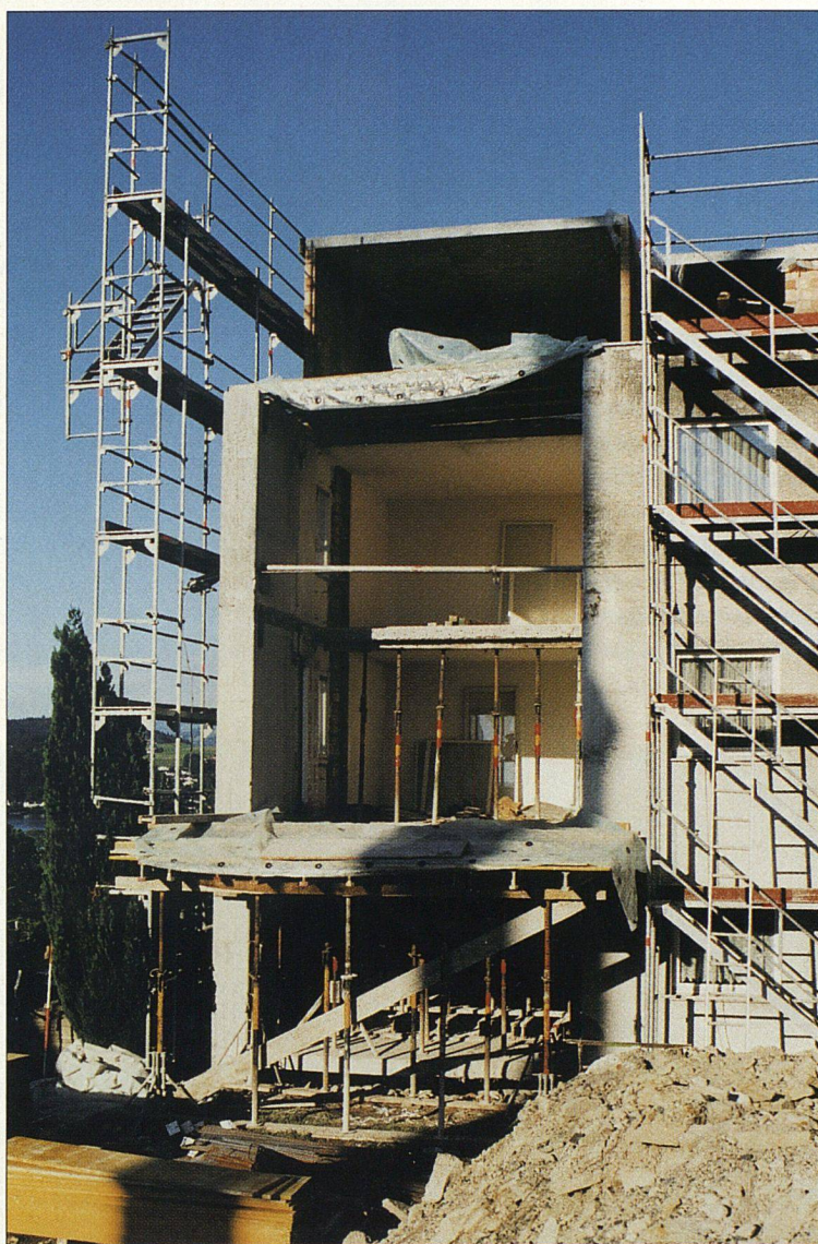
Das Leben war eine Baustelle – während 12 Wochen mussten die Mieter auf ihr Wohnzimmer verzichten.
