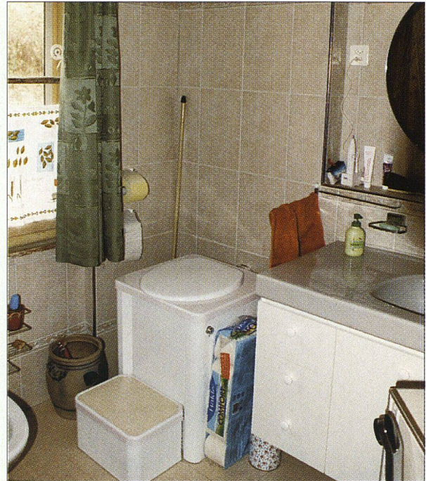
Die Komposttoilette, im Bild die «Etagentoilette» Typ Septum, hat aufgrund der zunehmenden Belastung der Gewässer wieder an Aktualität gewonnen.
