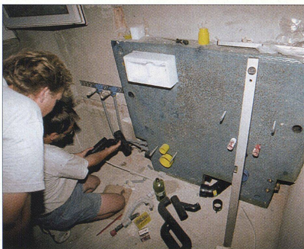
Beliebte Methode bei der Badrenovaton: Vorwandinstallationen.
