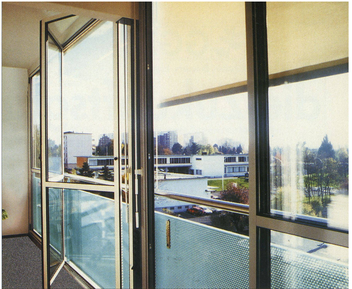
Ist die faltwand geöffnet, ragt sie weit in den Balkon hinein. Das wird von der Mieterschaft teilweise kritisiert.
