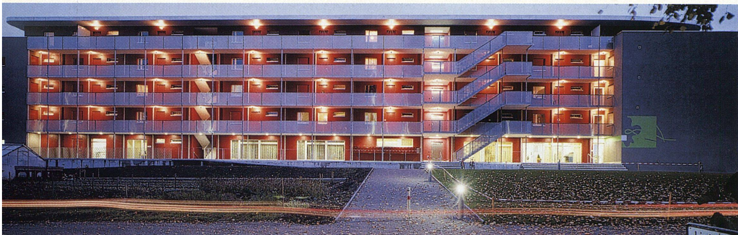
Ansicht des Flurgartens bei Nacht
