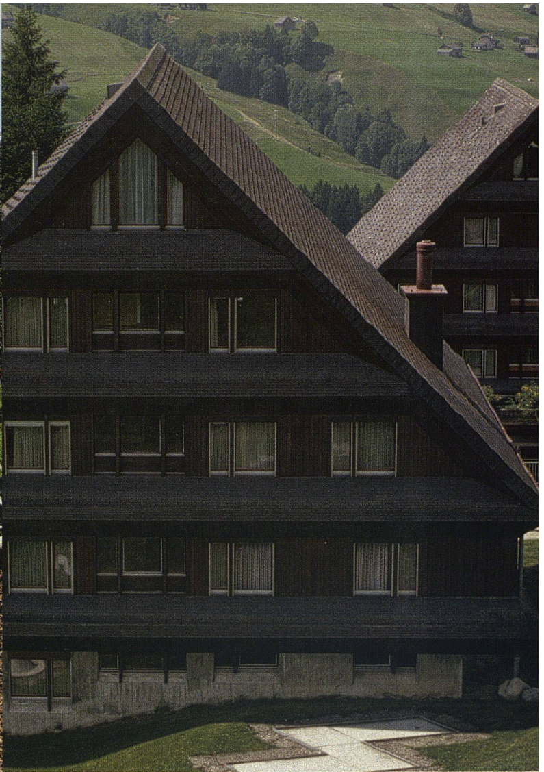
Wie riesenhafte Tobleronezacken stehen die Reka-Ferienhäuser am Hang.
