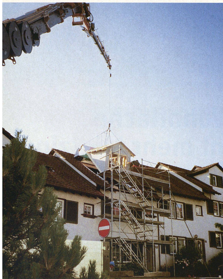
Kurze Bauzeit dank vorgefertigter Teile: Die fertigen Lukarnen setzt der Kran zielgenau aufs Dach.
