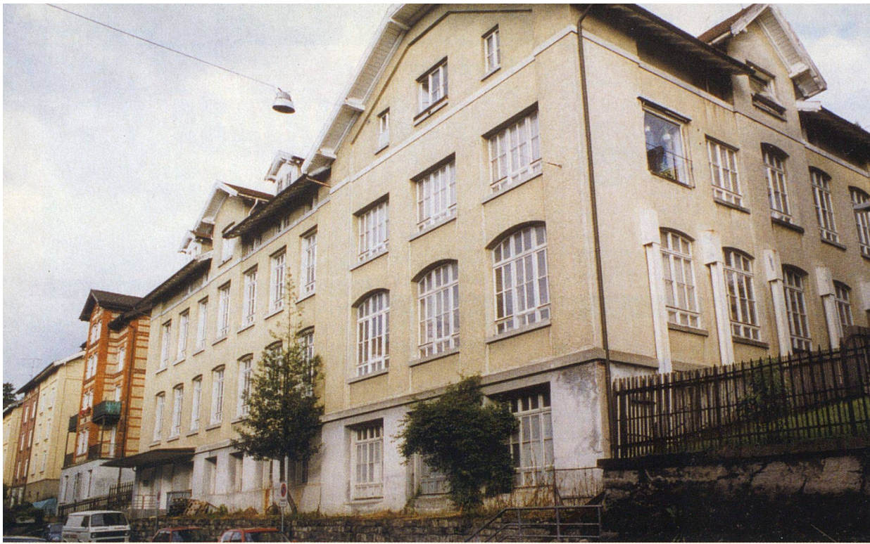
Die zentrumsnahe ehemalige Textilfabrik in St. Gallen steht vor dem Umbau. In einem Jahr sollten die 17 Wohnungen der Genossenschaft Solinsieme bezugsbereit sein.
