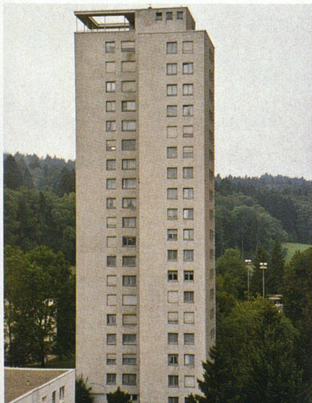
Das in den 60ern erstellte Hochhaus im alten Zustand
