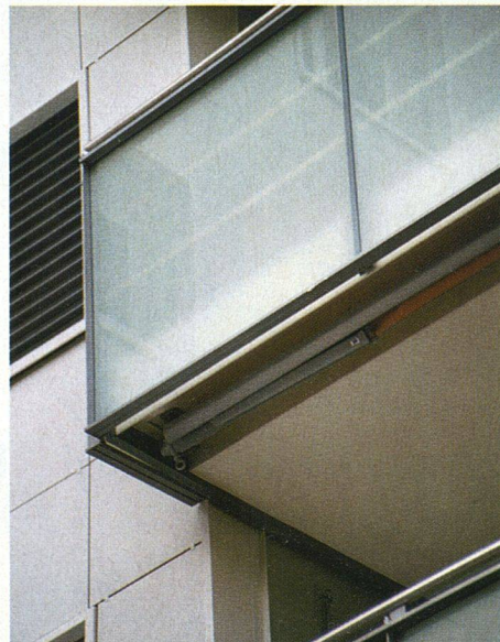
Die Verkleidung der vergrösserten Balkone im Detail
