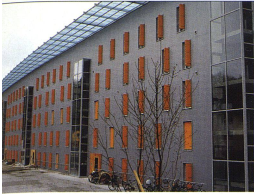
44 günstige Eigentumswohnungen hinter der Metallfassade: im Parterre mit direktem Gartenzugang, in den oberen Stockwerken mit Wintergarten. Die Raumeinteilung konnten die KäuferInnen selbst bestimmen.
