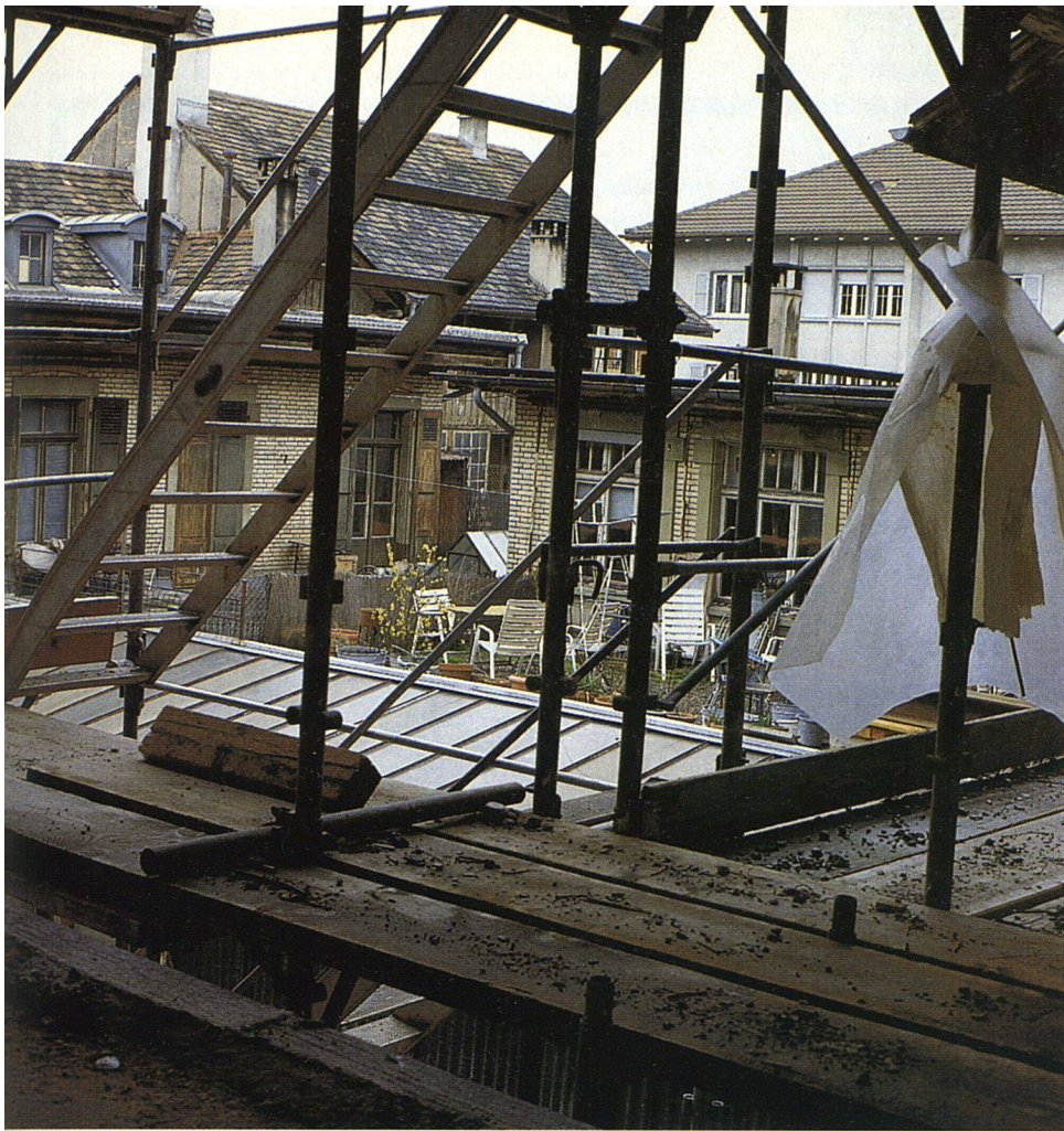
Blick von der Baustelle in den Innenhof. Der Altbau links soll in einer zweiten Etappe saniert werden.
