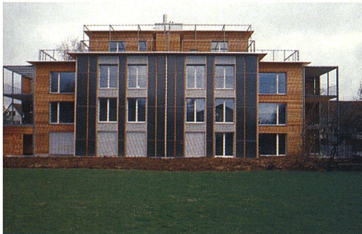
Grosse Fensterflächen und schwarze Sonnenkollektoren prägen die Südwestfassade.
