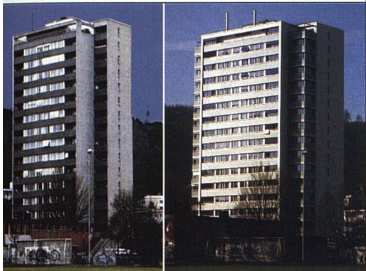
Graphika-Hochhaus. Ostfassade vor und nach der Sanierung.
