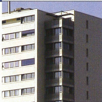
Ostfassade mit neuem Veranda-Anbau.
