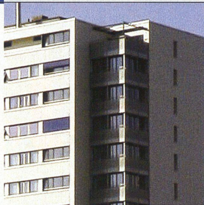
Ostfassade mit neuem Veranda-Anbau.
