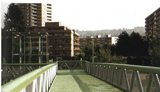
Die neue Passerelle soll die «Insel» Grünau mit Zürich-Altstetten verbinden.
