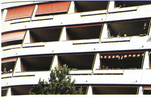
Der im Volksmund «Chinesische Mauer» geheissene Längsriegel wird von vielen als Brachial-Architektur empfunden, wie sie heute kaum mehr gebaut würde.
