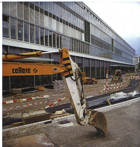
Das neue Quartier wächst rasch heran.
