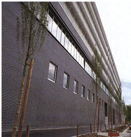
Für den urbanen MFO-Park sind die Erdarbeiten bereits im Gang (obere Bildreihe). In der Mitte und unten Impressionen aus dem sich rasch wandelnden ehemaligen Industriegebiet.
