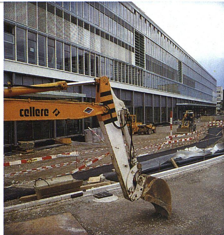
Das neue Quartier wächst rasch heran.
