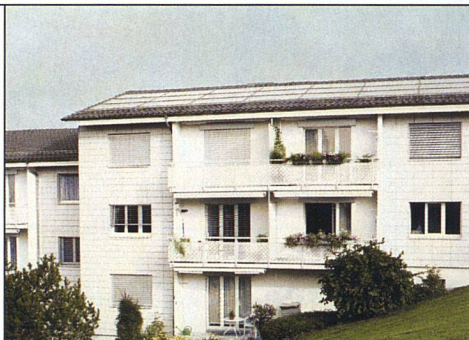
Achtzig Quadratmeter Sonnenkollektoren hat die BG Milchbuck auf den Dächern der Siedlung Höhenring installieren lassen.
