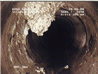
Kalkablagerung und Wurzeleinwuchs sind Schäden, die in Hausentwässerungsleitungen auftreten können.
