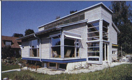
Dieses modern anmutende Wohnhaus in Bülach trägt das Minergie-Label. Es ist mit Faserzement «Eternit» in Stülpldeckung bekleidet.
