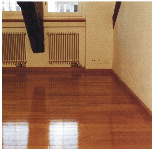
Riemenparkett in Umbau/Dachausbau.
