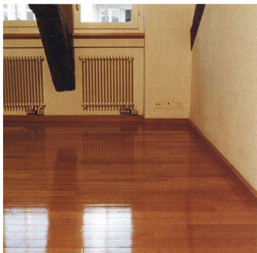
Riemenparkett in Umbau/Dachausbau.
