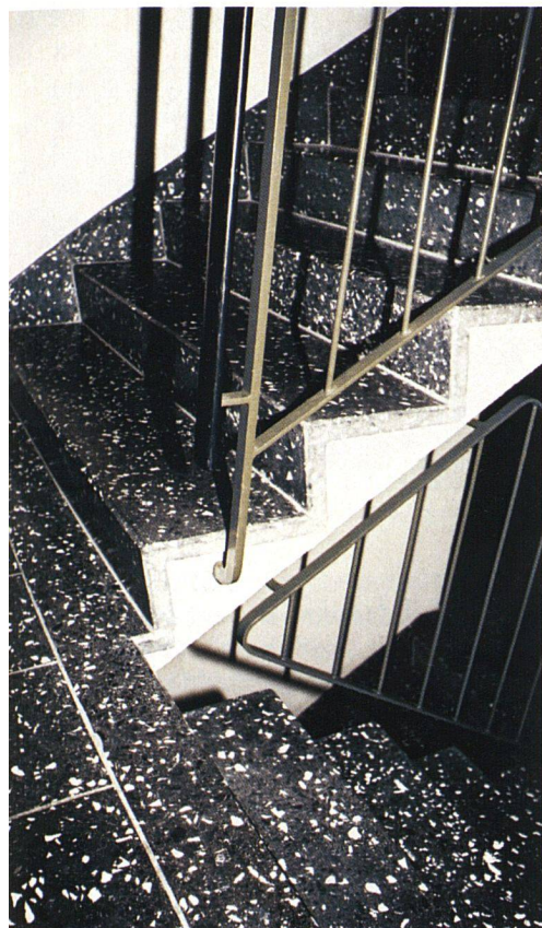
Traditionelle Treppe mit Stufen aus Kunststeinplatten und Metallgeländer in einem Mehrfamilienhaus in Zürich.
