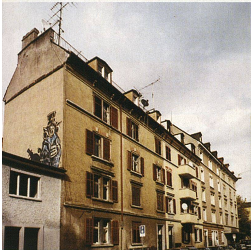
Das Haus Magnusstrasse 23 ist eingeklemmt zwischen einem zweistöckigen und einem gleich hohen Gebäude. Links vor der Sanierung, rechts nach der zehnwöchigen Umbauzeit mit neuen Balkonen.
