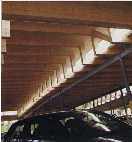
Eine überdeckte Parkfläche mit Tiefgeschoss findet sich am Rand der Siedlung.
