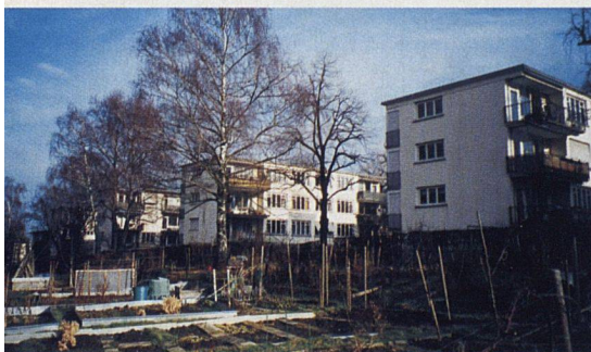
Gute Klimabilanz: Die Wärmepumpenzentrale der Genossenschaft Neubühl versorgt 230 Wohnungen in Zürich-Wollishofen und erspart der Umwelt im Vergleich zu früher 740 Tonnen Kohlendioxid im Jahr.
