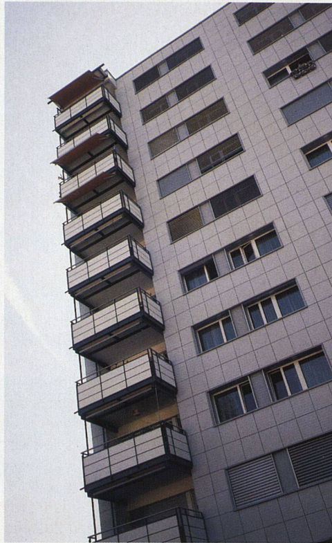
Ein Hochhaus ist bereits saniert.
