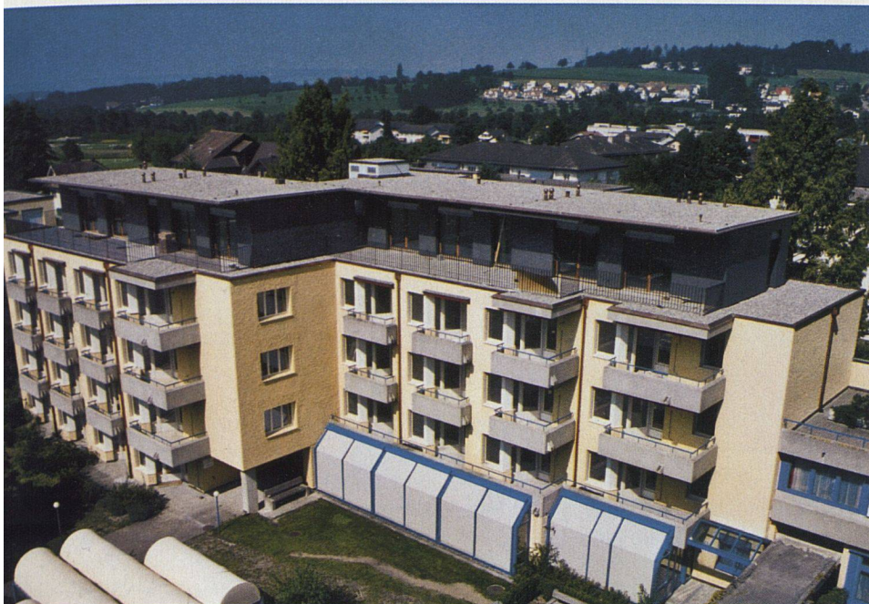
Die Liegenschaft der Genossenschaft für Alterswohnungen Baar nach dem Umbau und der Aufstockung mit den beiden Attikawohnungen.
