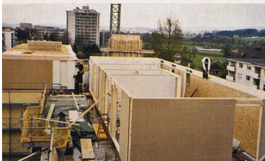
Aufbau der Attikawohnungen auf dem bestehenden Gebäude.
