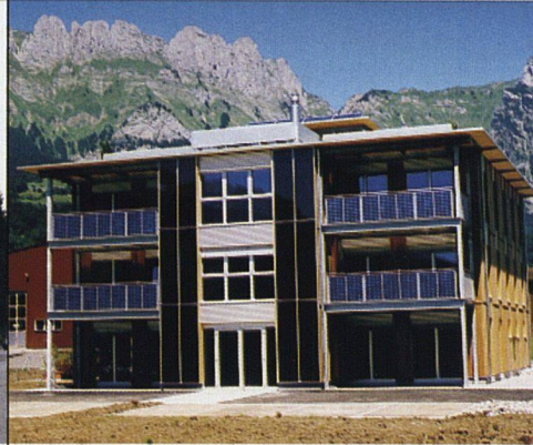
Mehrfamilienhaus in Gams (Fotovoltaik und Kollektoren)
