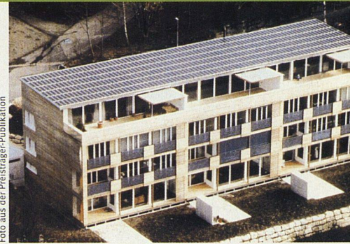
Zu den Solarpreisträgern 2002 gehört das Sechsfamilienhaus «Sunny Woods» in Zürich-Höngg. Mit dem Fotovoltaikdach erzeugt der Null-Heizenergie-Bau den Strom für die Wärmepumpe selbst. In die Brüstungselemente vor den raumhohen Fenstern sind zudem Vakuum-Röhrenkollektoren eingebaut.
