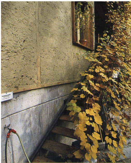
Detailansicht einer unverputzten Lehmwand.
