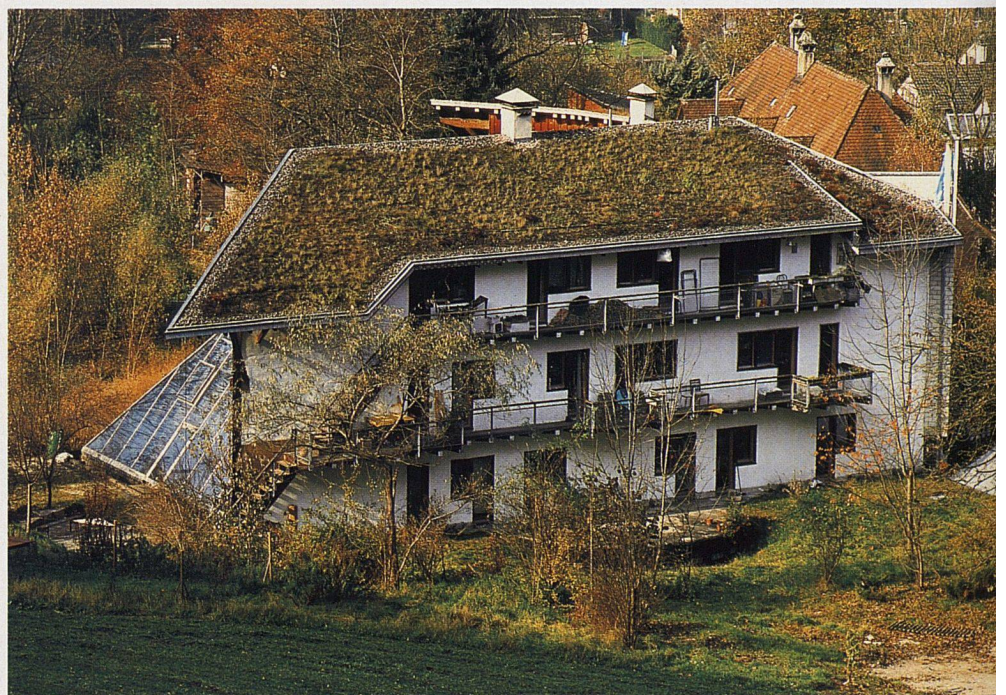
Wärmespeichernde Lehmbauweise und begrüntes Flachdach sind nur zwei der ökologischen Merkmale.
