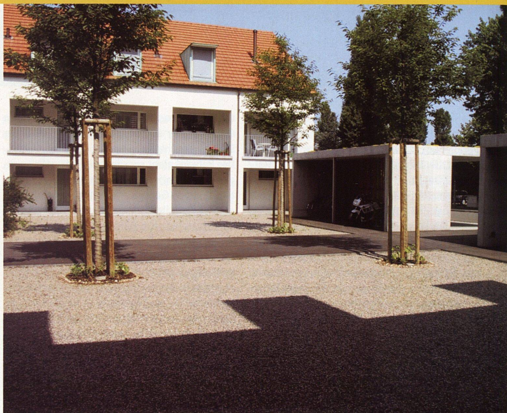
Die Seniorenwohngenossenschaft Pestalozzi in Muttenz BL musste Parkplätze bauen, die sie nicht braucht. Nun stehen die bekiesten Flächen im Innenhof leer, wertvoller Grünraum geht verloren.
