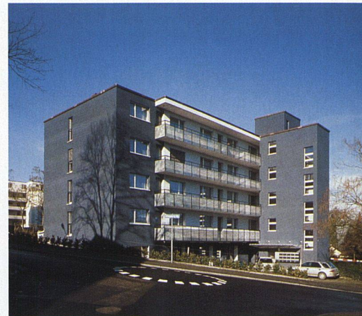
Die Bauten an der Friesenberghalde stammen vom bekannten Architekten Ernst Gisel. Er arbeitete bei der Farbgebung und vielen weiteren Details der Sanierung mit.
