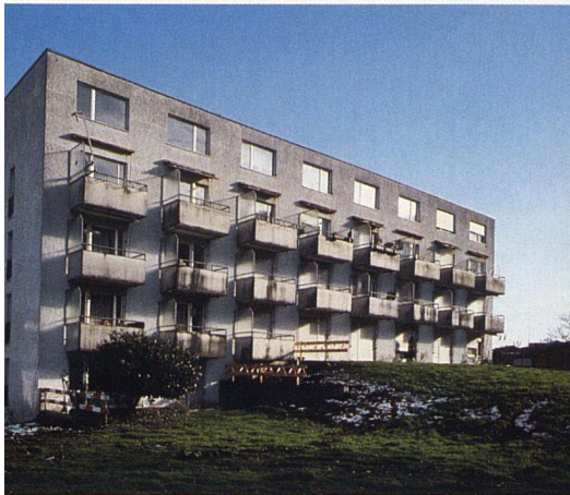
Laubenganghaus vorher – nachher: Neben der Innensanierung mit Wohnungszusammenlegungen erhielten diese Bauten neue Balkone.
