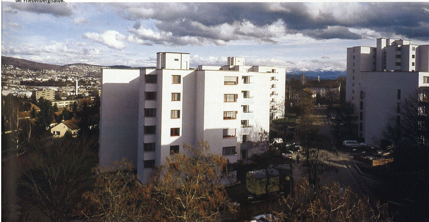
Die neu renovierten Punkthäuser an der Friesenberghalde.
