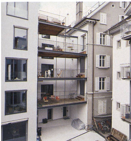
Der Neubau Gartenhofstrasse 27 teilt sich Erschliessung und Balkone mit dem alten Nachbarhaus.
