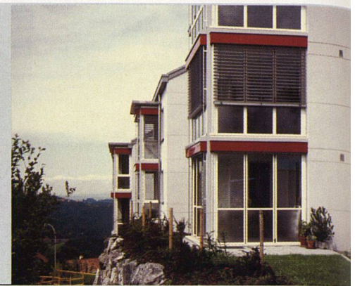
Die BewohnerInnen des neueren Siedlungsteils schätzen die grosszügigen verglasten Balkone, die 1996 zeitgleich mit der Fassadensanierung erstellt wurden.
