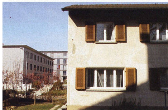
Bescheidene Reihenhäuschen, wie sie in der Nachbarschaft immer noch zu finden sind, schafften an der Unterfeldstrasse Platz für viel Wohnraum für Familien.
