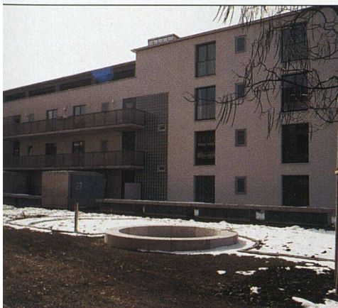
Die Gebäuderückseite mit dem Eingangsbereich. Verspieltes Detail: Glasbausteine streuen natürliches Licht in die Treppenhäuser.
