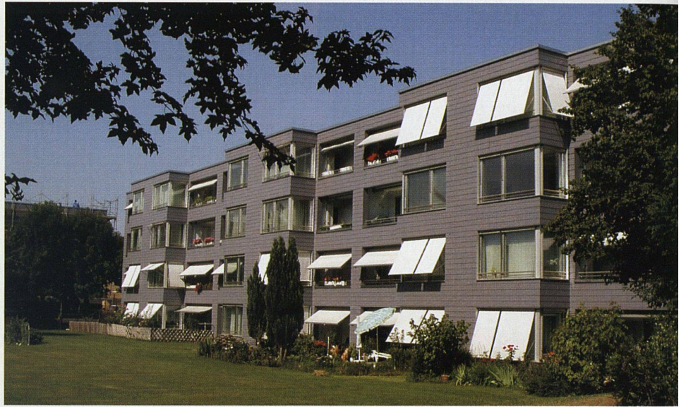
Eine besondere Knacknuss stellte die Sanierung der von Ernst Göhner in den 60er-Jahren erstellten Plattenbausiedlung Sunnebüel in Volketswil dar. Einerseits ging es darum, die 752 Wohnungen für die nächste Generation benutzbar zu machen. Andererseits mussten die Mietzinse bezahlbar bleiben. Im Bild eine Liegenschaft mit Erweiterungsanbauten.
