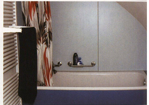
Die Badewanne ist so in die abgeschrägte Wand eingepasst, dass man auf einer Seite bequem einsteigen und duschen kann.
