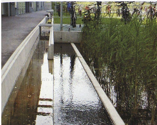
Wer das Regenwasser zwar nicht für den Hausgebrauch nutzen, aber zumindest nicht der Kanalisation zuführen will, dem empfiehlt sich eine Versickeranlage. Dies belastet die Kläranlage weniger und zahlt sich aus in geringeren Abwasserrechnungen. Im Bild das Regenwasser-Rückhaltebecken in der ABZ-Siedlung Regina-Kägi-Hof.
