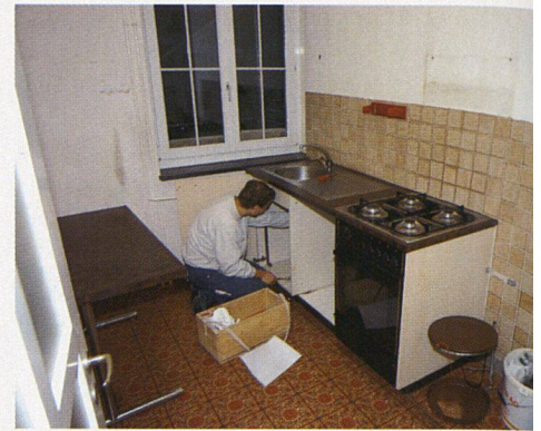
Auch wenn es schnell gehen soll: Gemäss den Erfahrungen von BfR entscheiden sich Baugenossenschaften bei Erneuerungen in der Regel für hochwertige Materialien. Hier das Beispiel einer Küchensanierung der Baugenossenschaft Holeestrasse, Basel.
