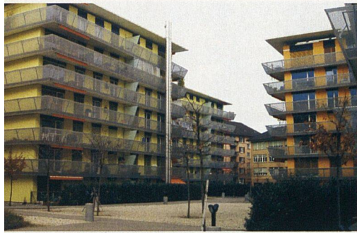
Für das Röntgen-Areal, an der Einfahrt zum Zürcher Hauptbahnhof gelegen, fanden die SBB lange keinen Investor. Erst Leopold Bachmann führte das Projekt des Architekturbüros Stürm und Wolf aus. Trotz Lärmimmissionen sind die zentral gelegenen, günstigen Wohnungen sehr beliebt.
