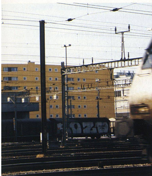
Leopold Bachmanns Siedlungen befinden sich oft dort, wo sonst niemand bauen will, etwa an stark befahrenen Bahnlinien. Lange Wohnzeilen schützen jeweils die Punkthäuser vor dem Lärm. Im Bild die Siedlung Micafil-Areal in Zürich.
