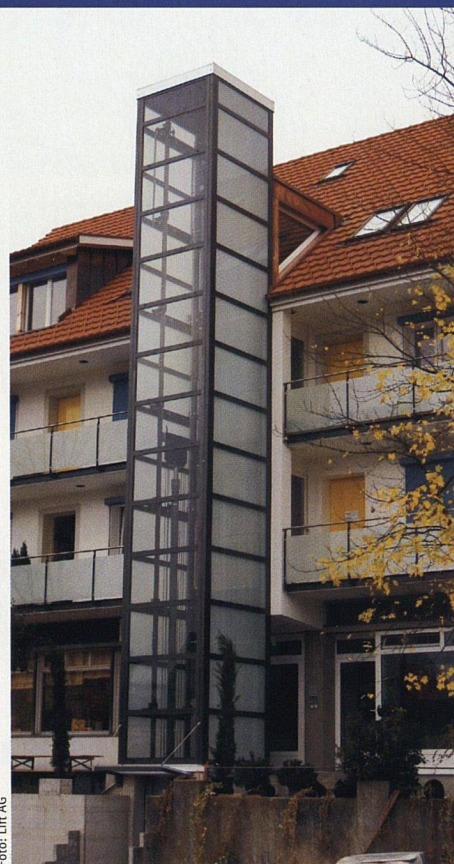
Foto: Lift AG
