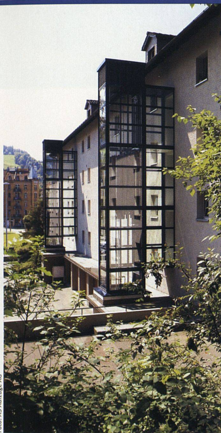
Foto: AS Aufzüge AG
