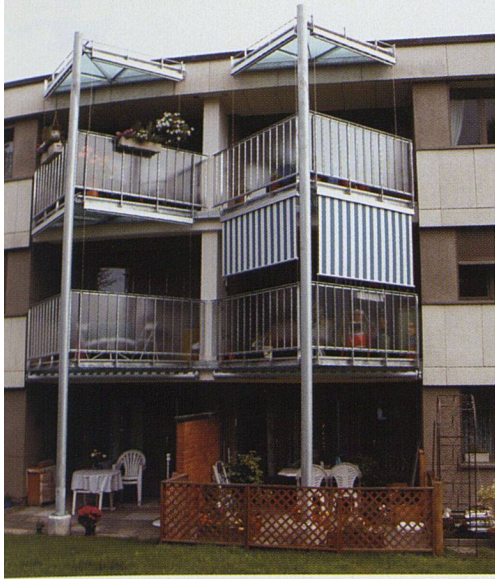
Für die 60er-Jahr-Siedlung der Baugenossenschaft Rotach in Rümlang erwiesen sich Balkonbauten in Dreieckform nicht nur ästhetisch als gute Lösung: Die Wohnungen gewannen gar an Tageslicht.
