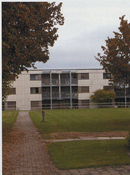
Die neuen Balkone fügen sich unauffällig ins Erscheinungsbild.
