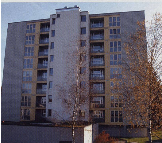
Beim Hochhaus der ASIG (links) wurden die Laubengänge für Wohnungserweiterungen benutzt.
