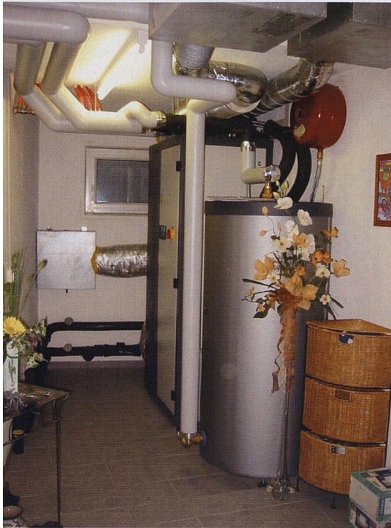
Speziell für Minergie-Einfamilienhäuser entwickelte Standard-Kompaktenergiezentralen heizen, kühlen, lüften und stellen das Warmwasser bereit: energieeffizient, platzsparend, zuverlässig und einfach installierbar.
