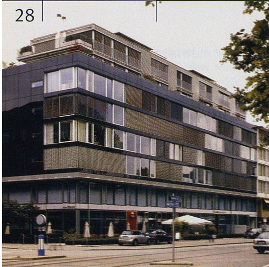
Beim Neubau an der Zürcher Kasernenstrasse arbeitet die UBS mit dem renommierten Architekten Bob Gysin zusammen.
