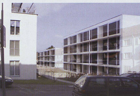
Die beiden Mehrfamilienhäuser (rechts) schliessen die Überbauung «Unterer Schweighof» ab.
