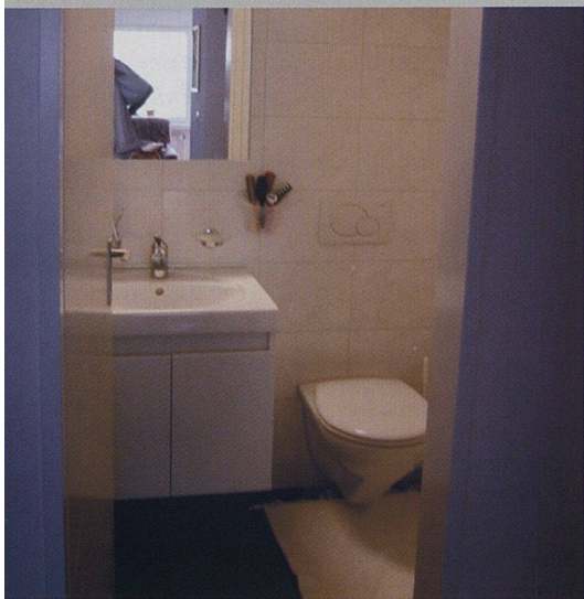
Ein grosser Waschtisch mit Schrank findet sich in den Bädern. Die neuen Leitungen verdeckt eine Vorwandkonstruktion.
