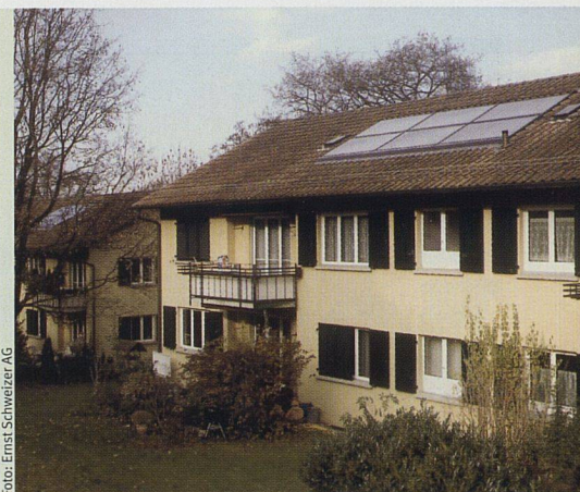
Solare Vorwärmung des Warmwassers in der Überbauung Neuguet (Baugenossenschaft Hagenbrünneli).
